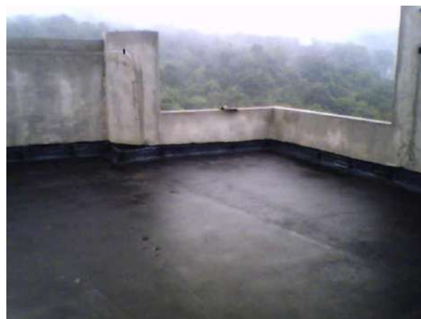
Figura – Imprimação da superfície
