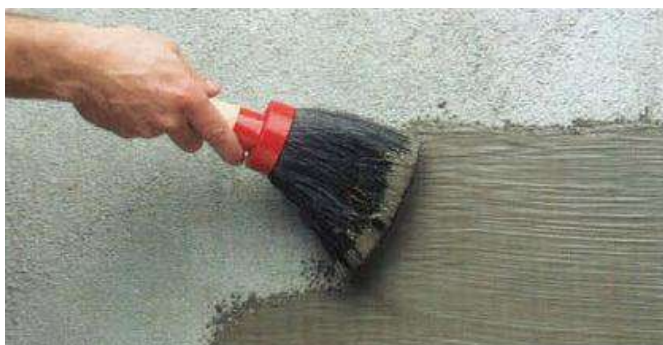
Figura – Aplicação de argamassa polimérica na forma de pintura.
