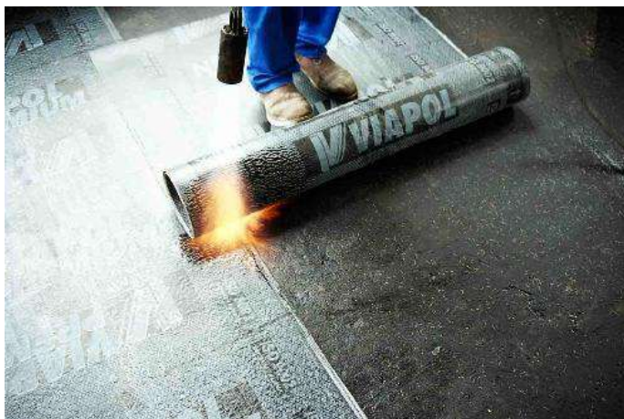
Figura – Execução de manta asfáltica com maçarico.
