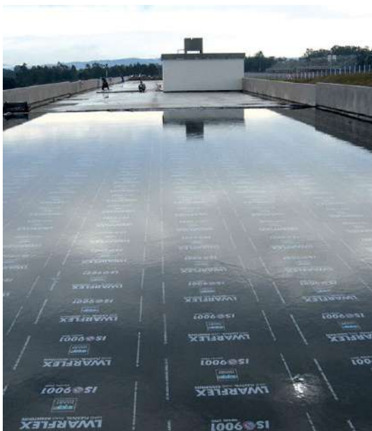
Figura – Teste de estanqueidade.
