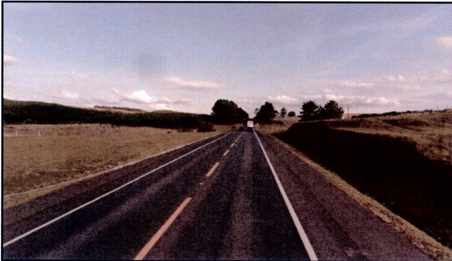
Pista Sul – Vista da pista sentido Rio Grande do Sul
