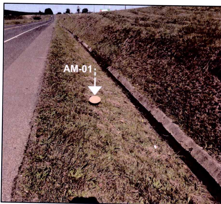
Figura 6.1 - Aspecto da região próxima ao trecho de projeto.
