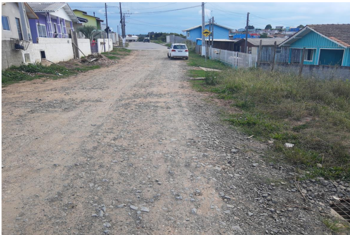
Foto 06- Pavimentação nova será executada em CBUQ
