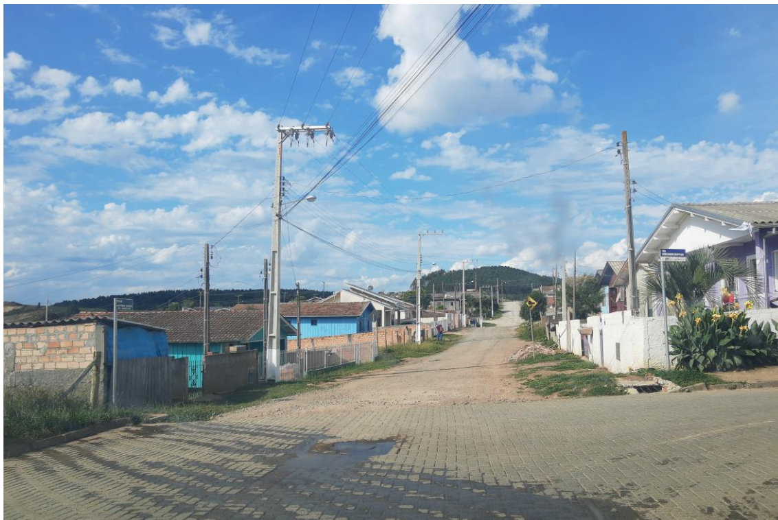
Foto 01- Início da Pavimentação em CBUQ
