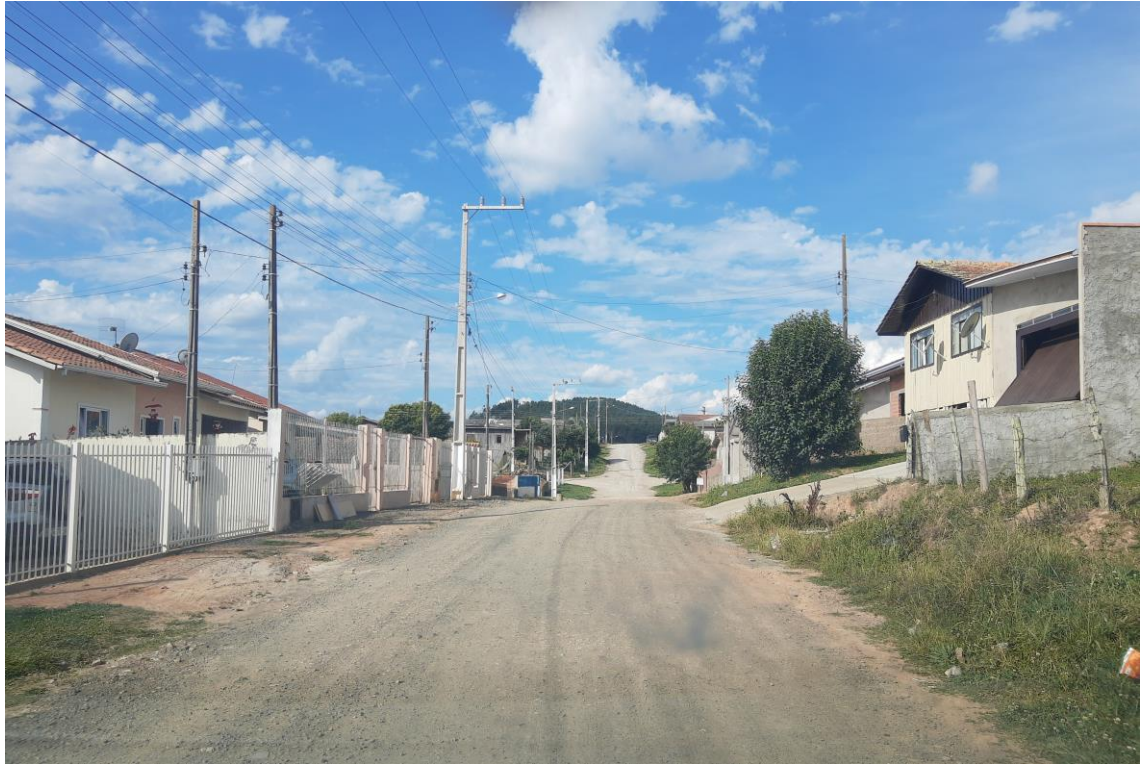
Foto 02- Será executado rebaixo de entrada de garagens
